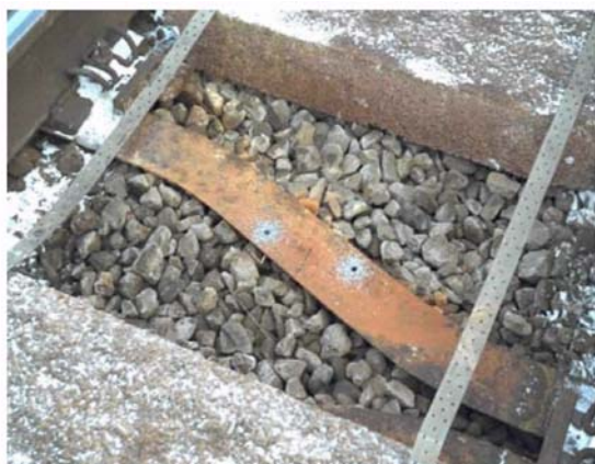
Obr. 13: Upevňovacie otvory v ocelovom podvale Y
