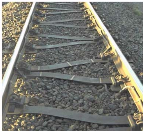
Obr. 11: Koľaj s ocelovými podvalmi Y
