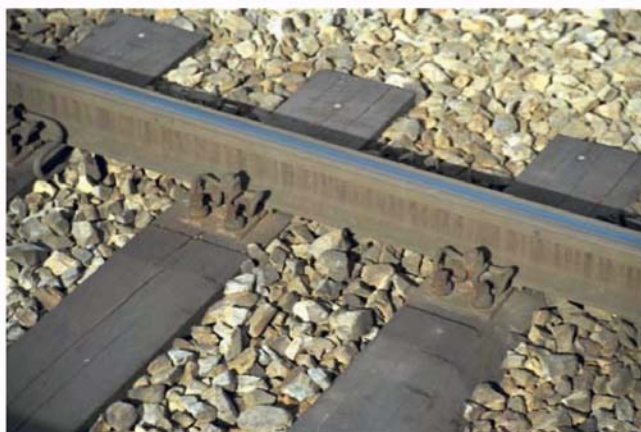
Obr. 2: Ohobľované dosadacie plochy dosiek (železničný zvršok KS)
