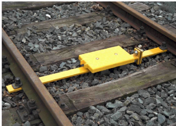
Obr. 18: Nosič balízy s balízou S 21 namontovaný bez šikmej podložky
