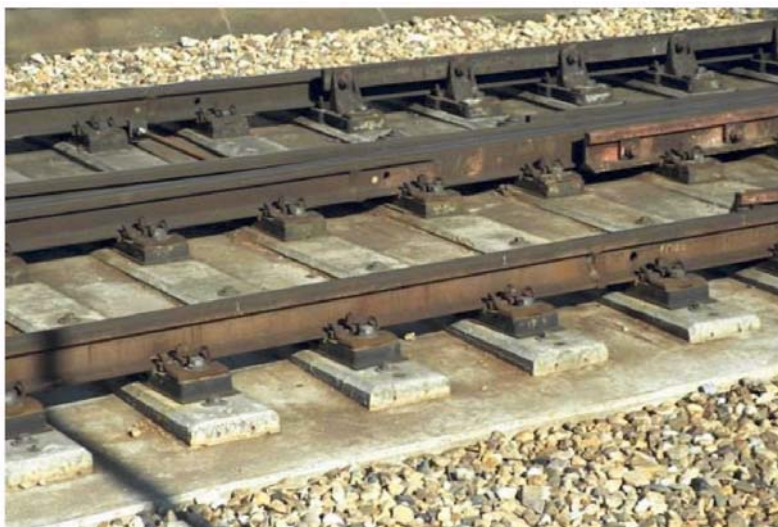
Obr. 17: Výškovo a stranovo nastaviteľné pružné upevnenie koľajníc pre výhybky
